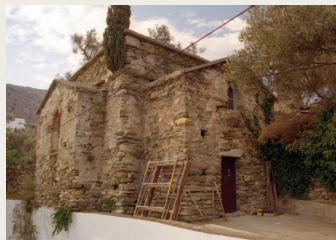
Εικ. 10. Γενική άποψη του χώρου από Ν., πριν από την έναρξη των εργασιών.
