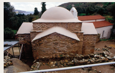
Εικ. 13. Ανωδομή του ναού, μετά το πέρας των εργασιών.
