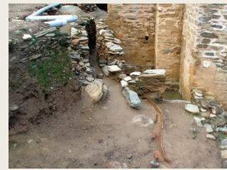
Εικ. 11. Αναλημματικοί τοίχοι κατά μήκος της πλευράς της δυτικής κεραίας.
