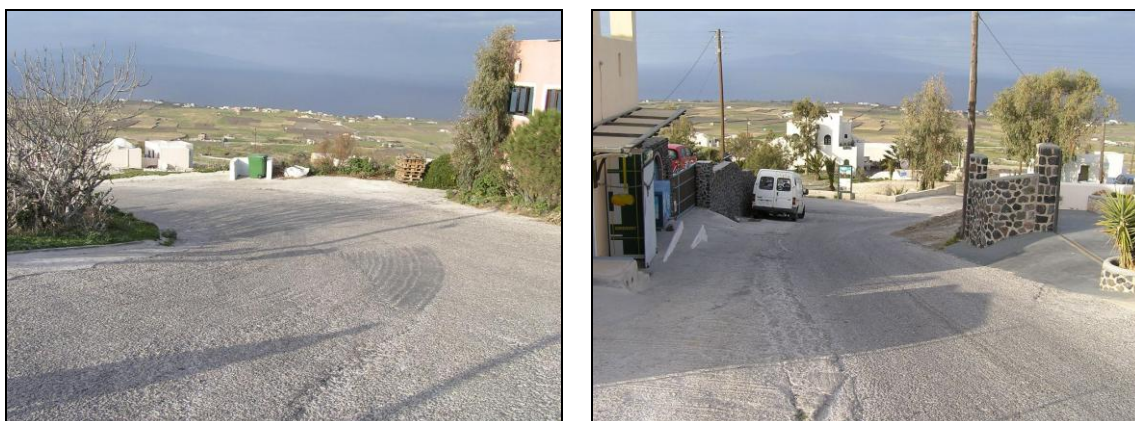
Εικ. 4: Τα δύο σημεία σημαντικών κλίσεων της κοινοτικής οδού Φοινικιάς-Παραδείσου στην περιοχή της Φοινικιάς
